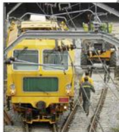
Treballa abans al migdia a l'estació dels 'Catalans'
